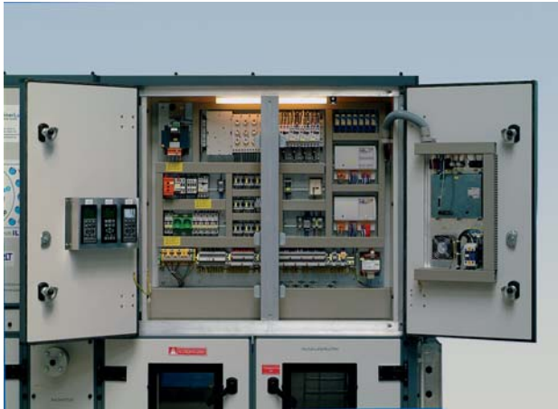
Painel de controle com módulo DDC
